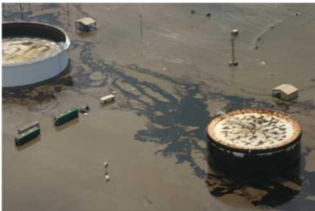
Фигура 1. Нефено петно, образувано след повреда от наводнение в резервоари за съхранение в Кофивил, САЩ, 2007 г. (Снимка: Граждански въздушен патрул на Канзас)
